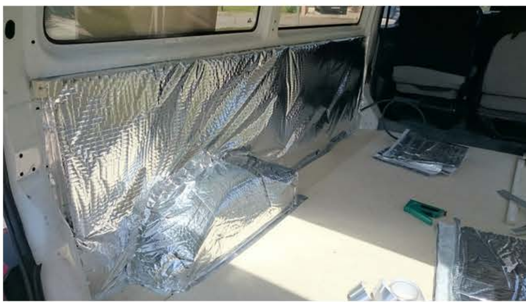
Les passages de roue sont isolés avec un isolant multicouches.
