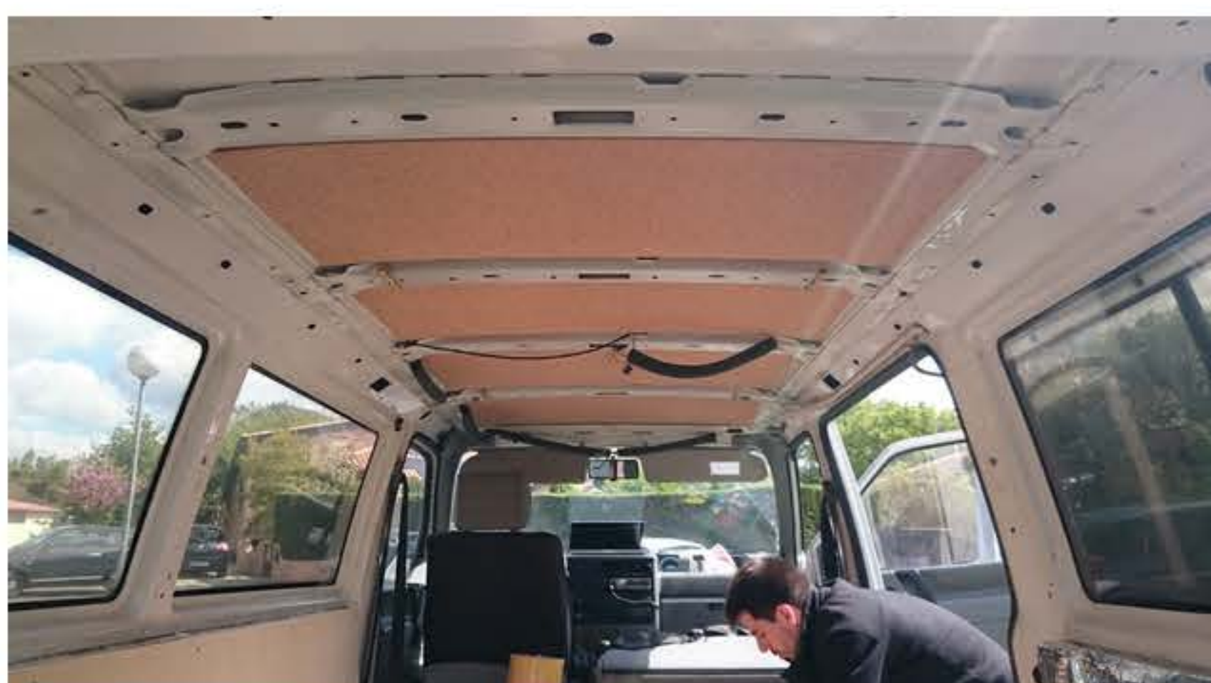
Liège collé au plafond avec la colle haute température.
