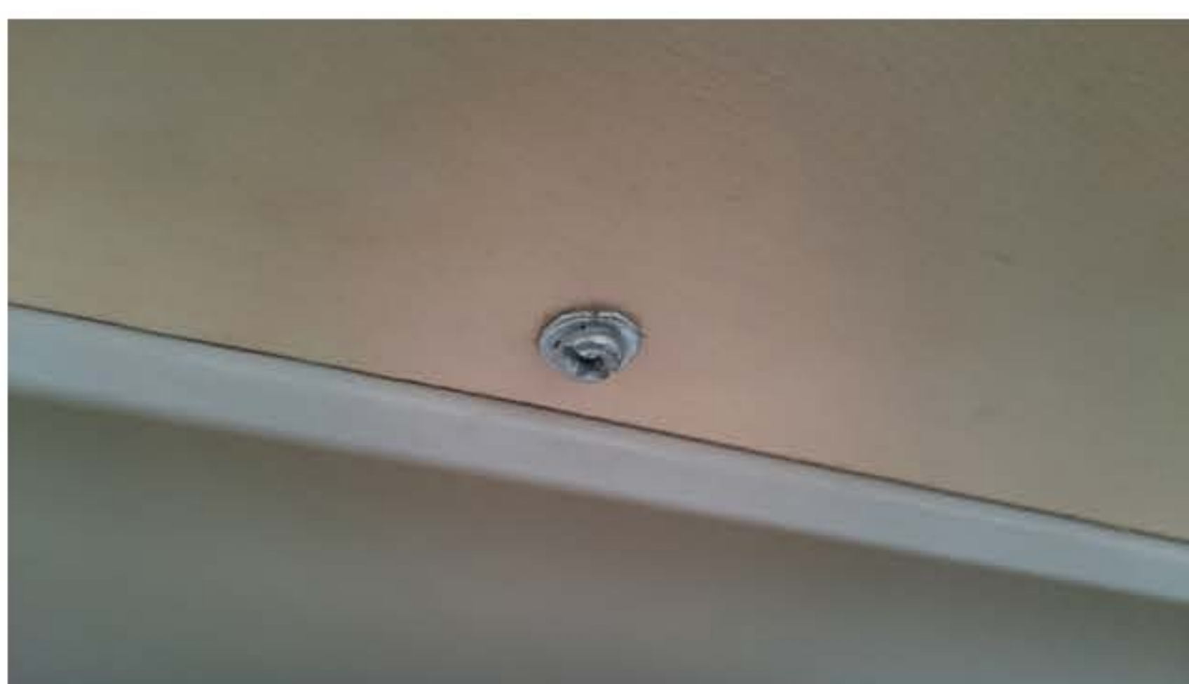
Le système de fixation avec cheville et vis à expansion.
